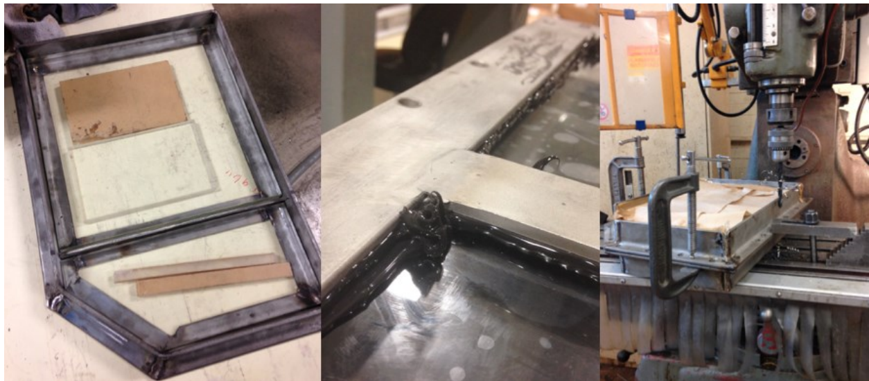
Figure 38 – Étapes de construction pour l'installation des fenêtres dans leur cadrage (image de gauche), le collage au silicone (image du centre) et le perçage des trous autour des cadres (image de droite)
