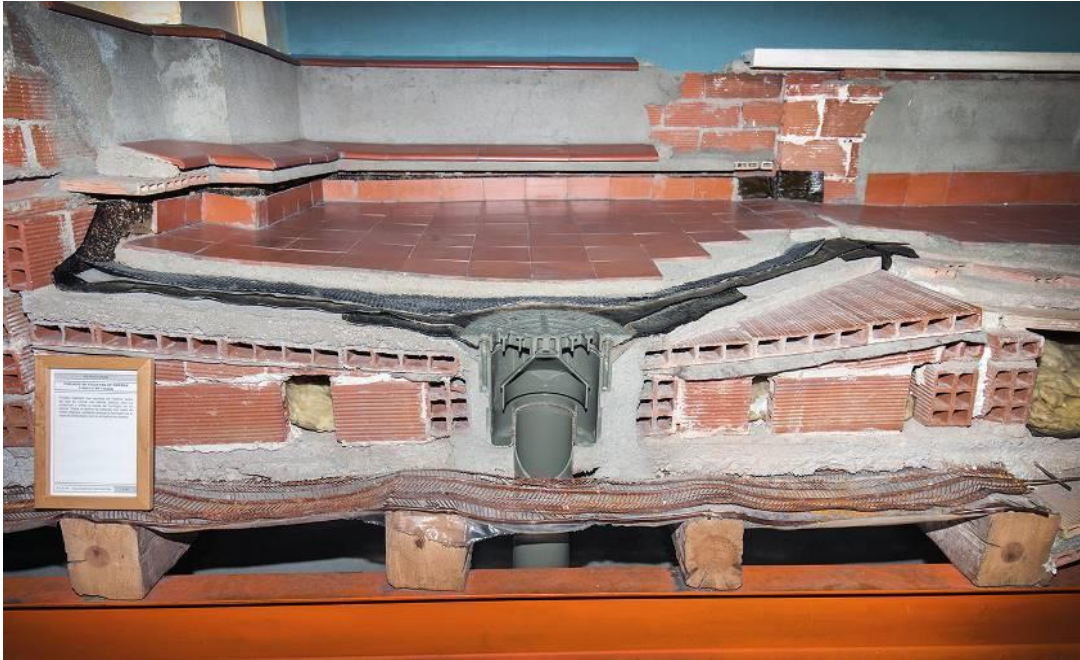
Figure 3.5 Picture of a model representing the Catalan Roof. Source: Universidad Politécnica de Madrid (2015, April 9). Aula-museo de construcción. ETSEM. DCAC. Retrieved June 8, 2018, from Flickr Oficial de la Universidad Politécnica de Madrid: https://www.flickr.com/photos/universidadpolitecnica/17860736216/in/photostream/
