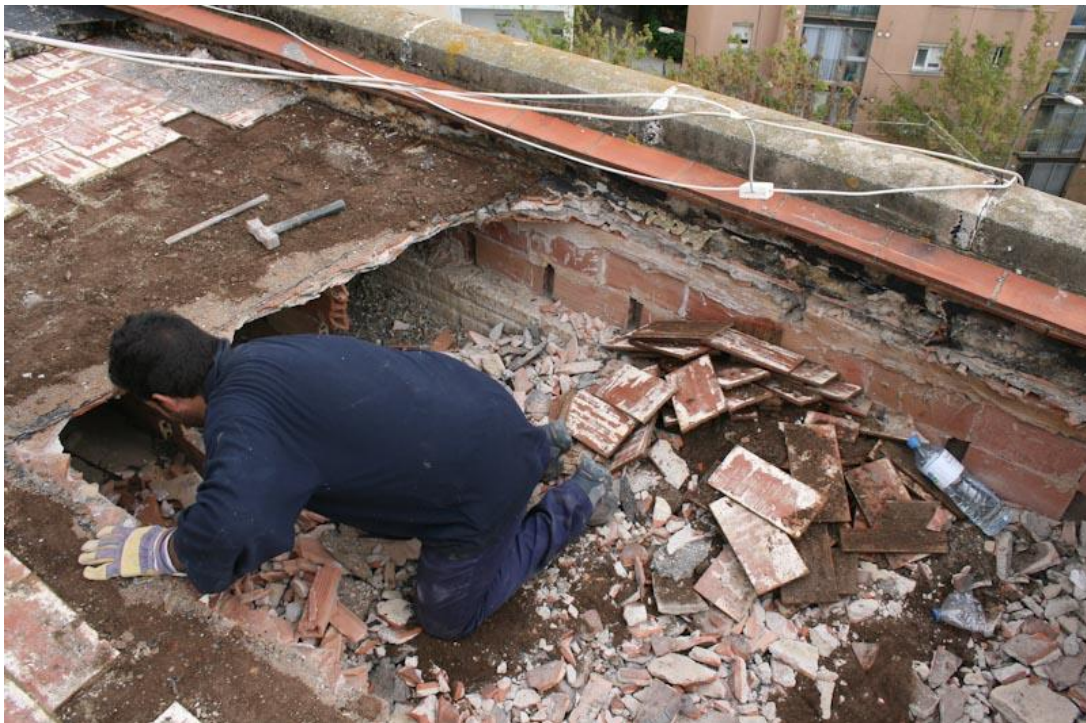
Figure 3.5 Picture of a model representing the Catalan Roof. Source: Universidad Politécnica de Madrid (2015, April 9). Aula-museo de construcción. ETSEM. DCAC. Retrieved June 8, 2018, from Flickr Oficial de la Universidad Politécnica de Madrid: https://www.flickr.com/photos/universidadpolitecnica/17860736216/in/photostream/
